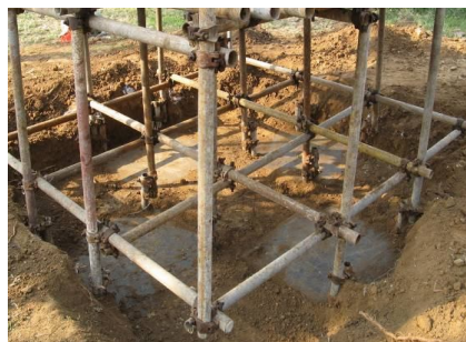
图 12 底板托换 Fig.12 Base slabs underpinning
