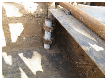
图 11 立柱的接长 Fig.11 Lengthening columns
