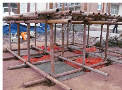
图7 搭设好的脚手架 Fig.7 Fixed scaffold
